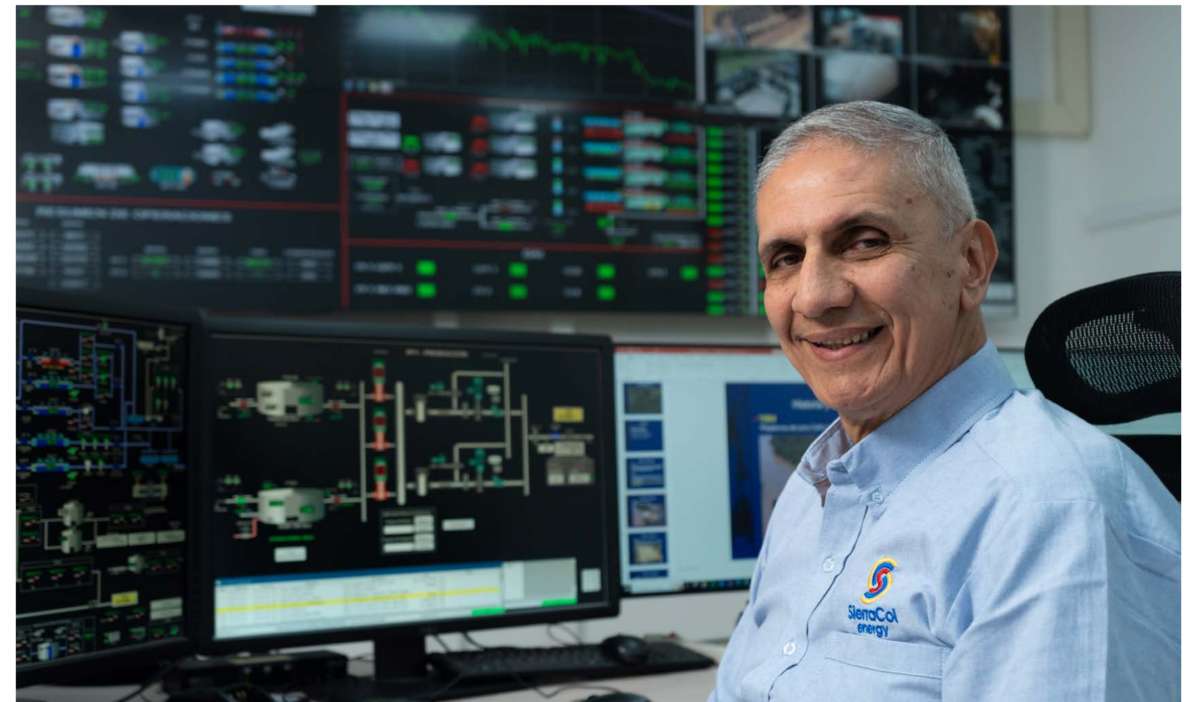
Cuarto de control, área de Caño Limón
