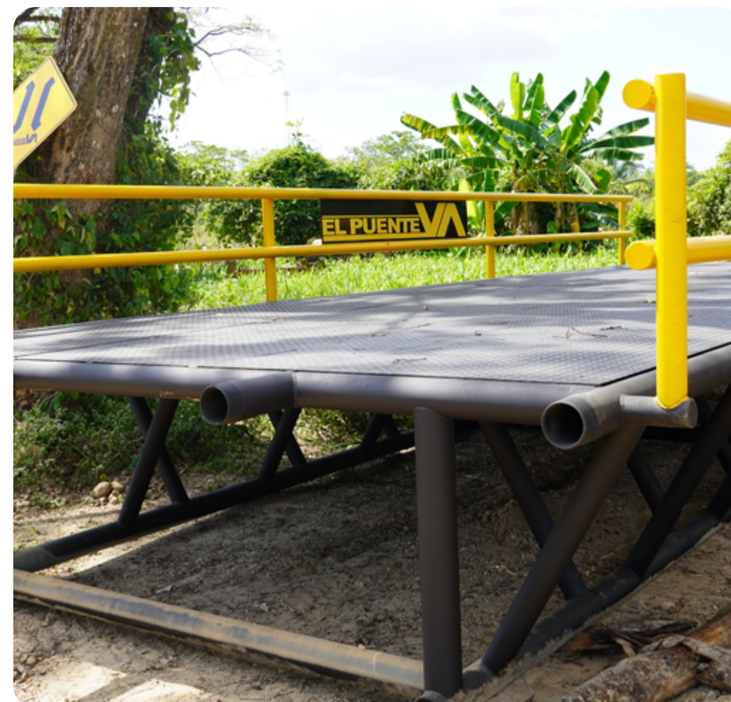
Iniciativa de tubería remanufacturada, área de Caño Limón
